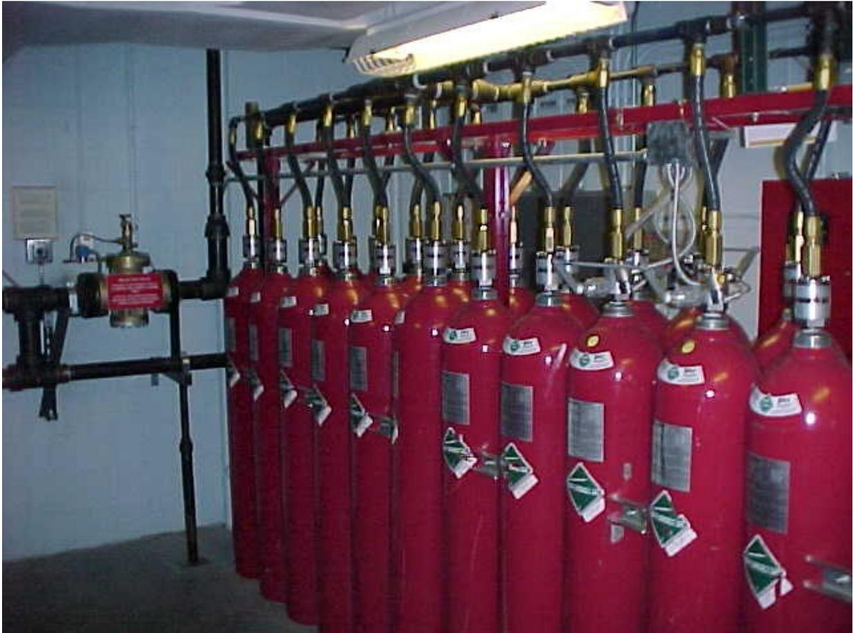
**Batería de Cilindros de Gas Licuado de Alta Presión**
